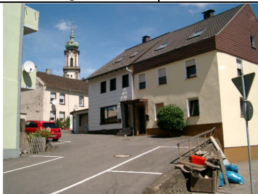
Foto: Ist-Zustand Brunnenstraße 5-9
