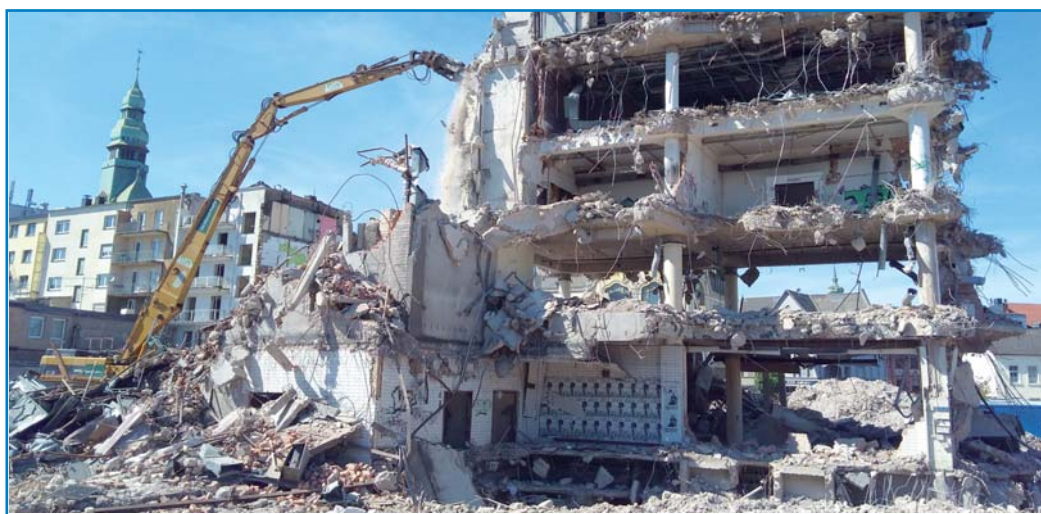
Momentaufnahme während der Abrissarbeiten
