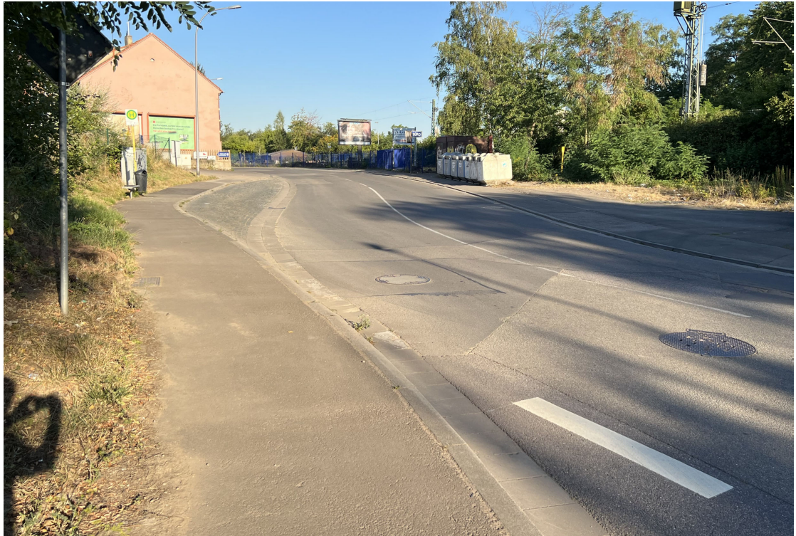
Abb. 3: L271 Saarbrücker Straße in Fahrtrichtung Fürstenhausen
