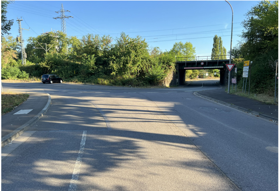
Abb. 5: Knotenpunkt L271 Saarbrücker Straße / Am Holzplatz aus Richtung Straße „Am Holzplatz“
