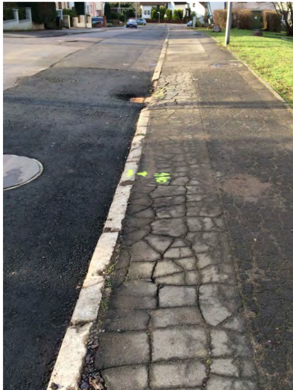
Abb. 44: Beispiele für Straßen- und Gehwegschäden in der östlichen Kurt-Schumacher-Straße (links) sowie in der Saarbrücker Straße 31a-33d (rechts)
