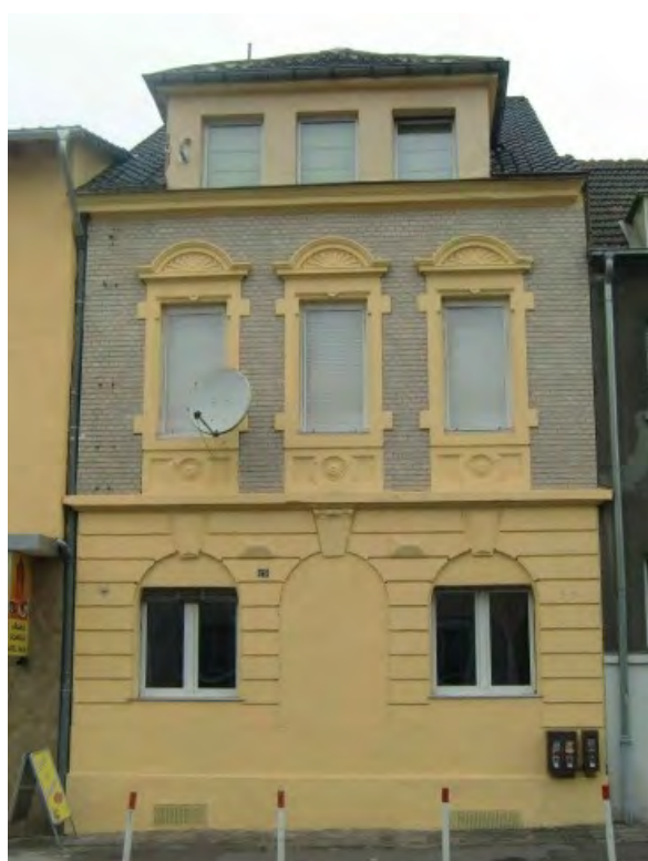
Abb. 39: Beispiele historische Bausubstanz
