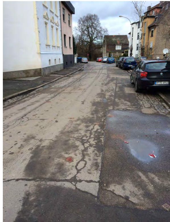
Abb. 44: Beispiele für Straßen- und Gehwegschäden in der östlichen Kurt-Schumacher-Straße (links) sowie in der Saarbrücker Straße 31a-33d (rechts)
