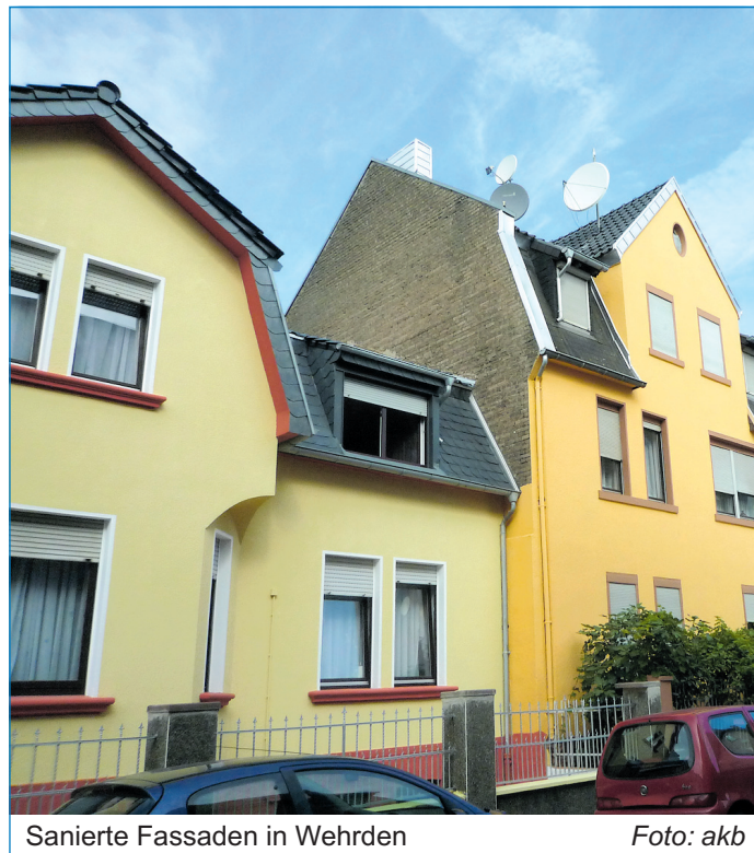
Sanierte Fassaden in Wehrden Foto: akb
