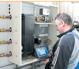
Wartung einer Fernwärme-station Foto: swv
